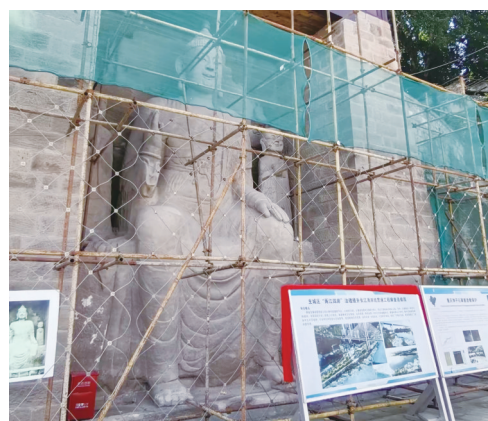
已采取防护措施的全省重点文物保护单位弹子石摩崖造像(左);强降雨间隙,重庆忠县文物部门组织对文物依托崖壁进行临时支撑加固(右)。
