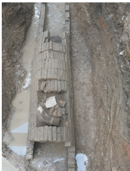
排水设施北段区域
