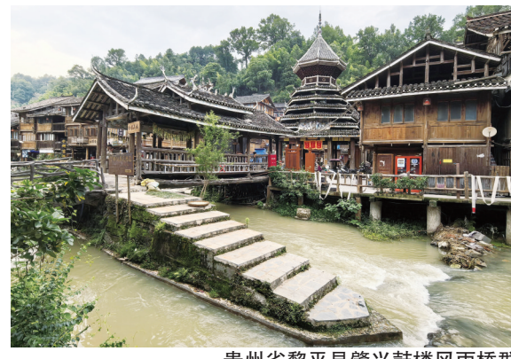
贵州省黎平县肇兴鼓楼风雨桥群
