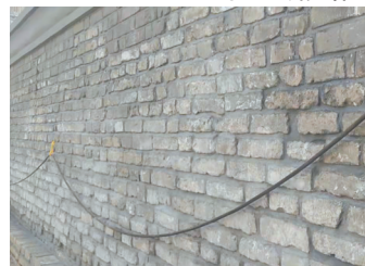
老院墙修复后
