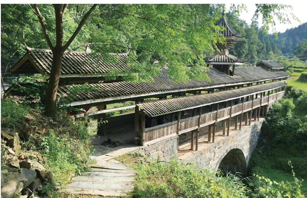
木梁柱廊桥——梁架回龙桥
