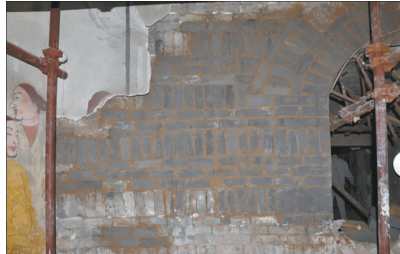
墓室南壁结构失稳修复后
