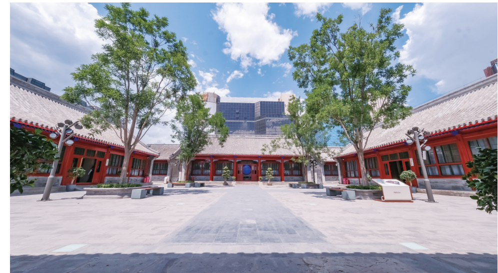
西院三进院(修缮后)
