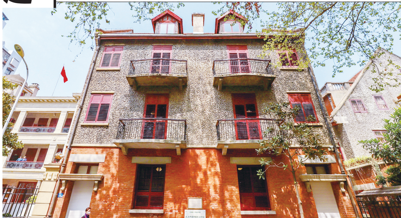
武汉中共中央机关旧址
