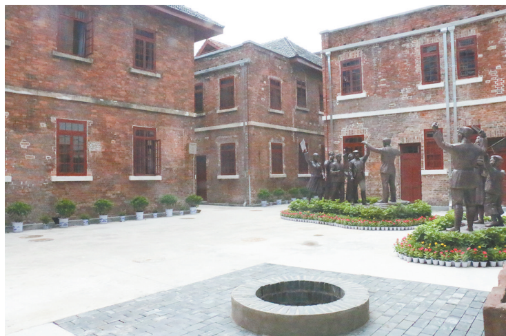
修缮后的盐商旧居院落内景
