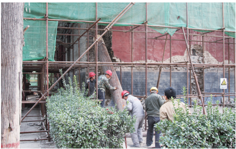
更换西北角柱
