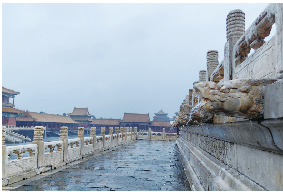
故宫太和殿前的排水系统
