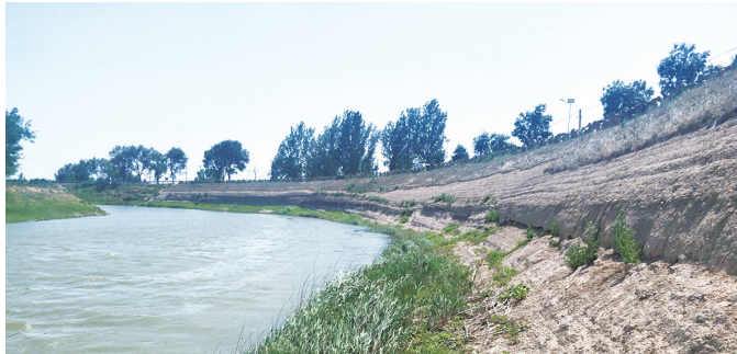
华家口夯土险工
