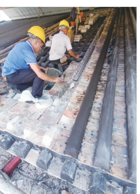
旧址屋顶瓦面修缮铺设
