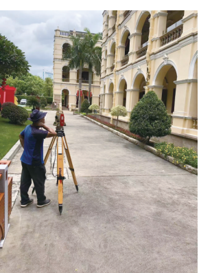
开展旧址沉降变形监测
