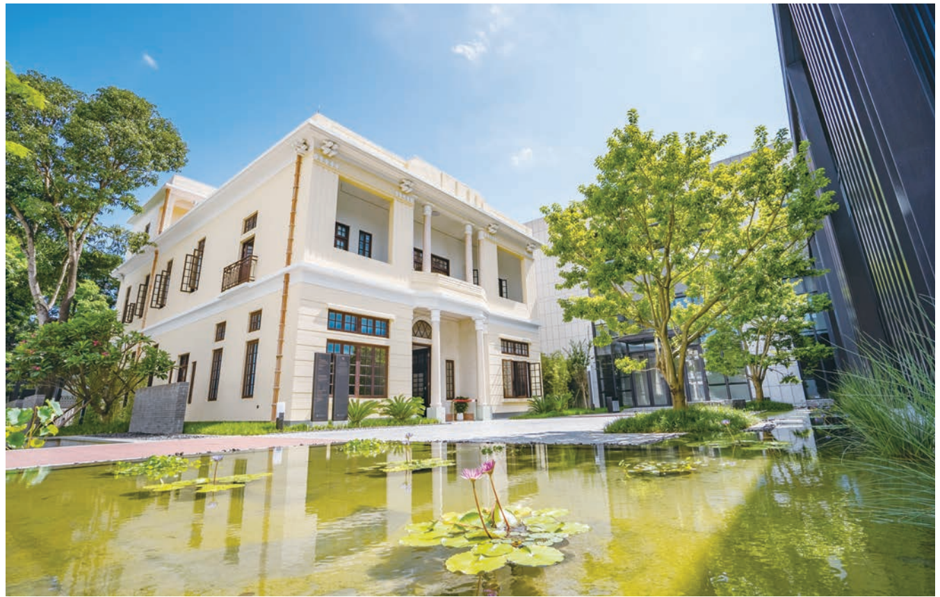
新老建筑和合共生
