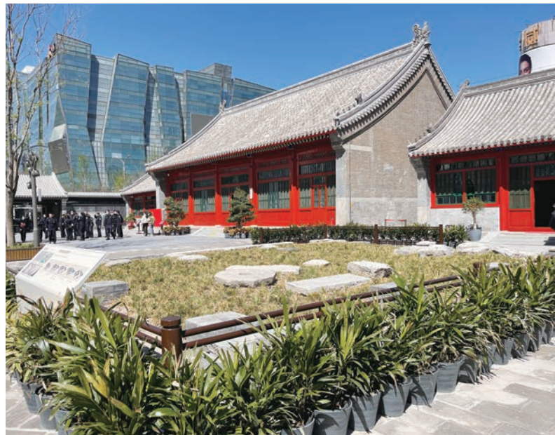
西一进院东厢房遗址
