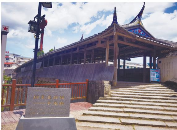
廊桥是在桥面上覆盖有廊屋或者楼阁，也称“风雨桥”，除能够荫蔽行人之外，也可起到保护木构桥面的作用。而楼阁与桥梁相结合，不仅遮风避雨，也可追求美观、表达精神诉求，成为了建筑艺术品。
