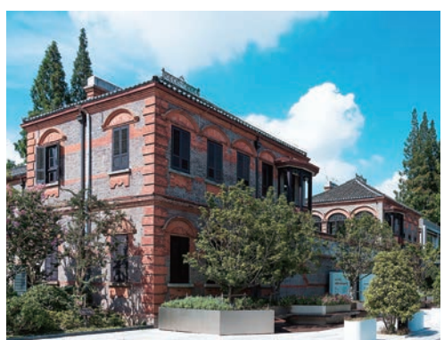
南通群英馆东馆历史建筑
