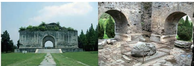
睿功圣德碑楼维修前后对比
