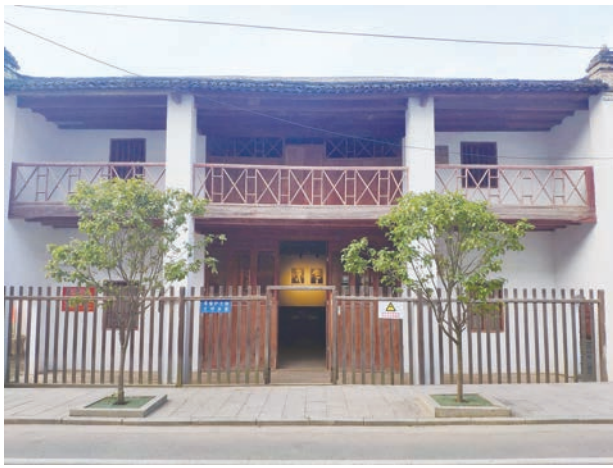
万安暴动行动委员会旧址全景照(维修前后)
