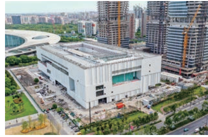
建设中的东馆
