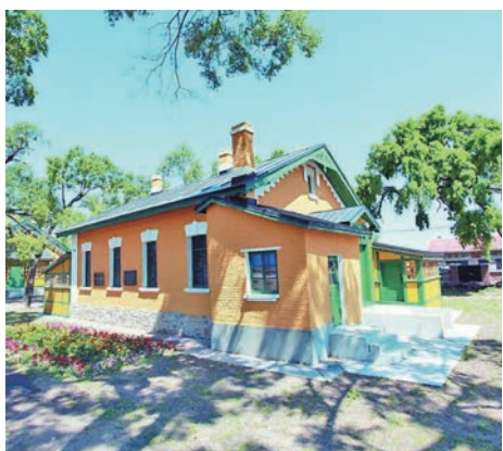
昂昂溪中东铁路建筑群——俄式民居
