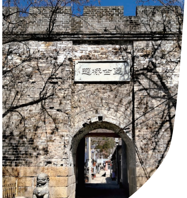
遥桥峪堡南墙东段
